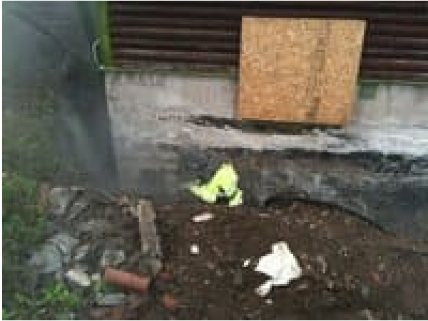
Blästring av grund innan dränering och isolering.
