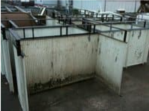
Balkongräcken innan rostskydd.
