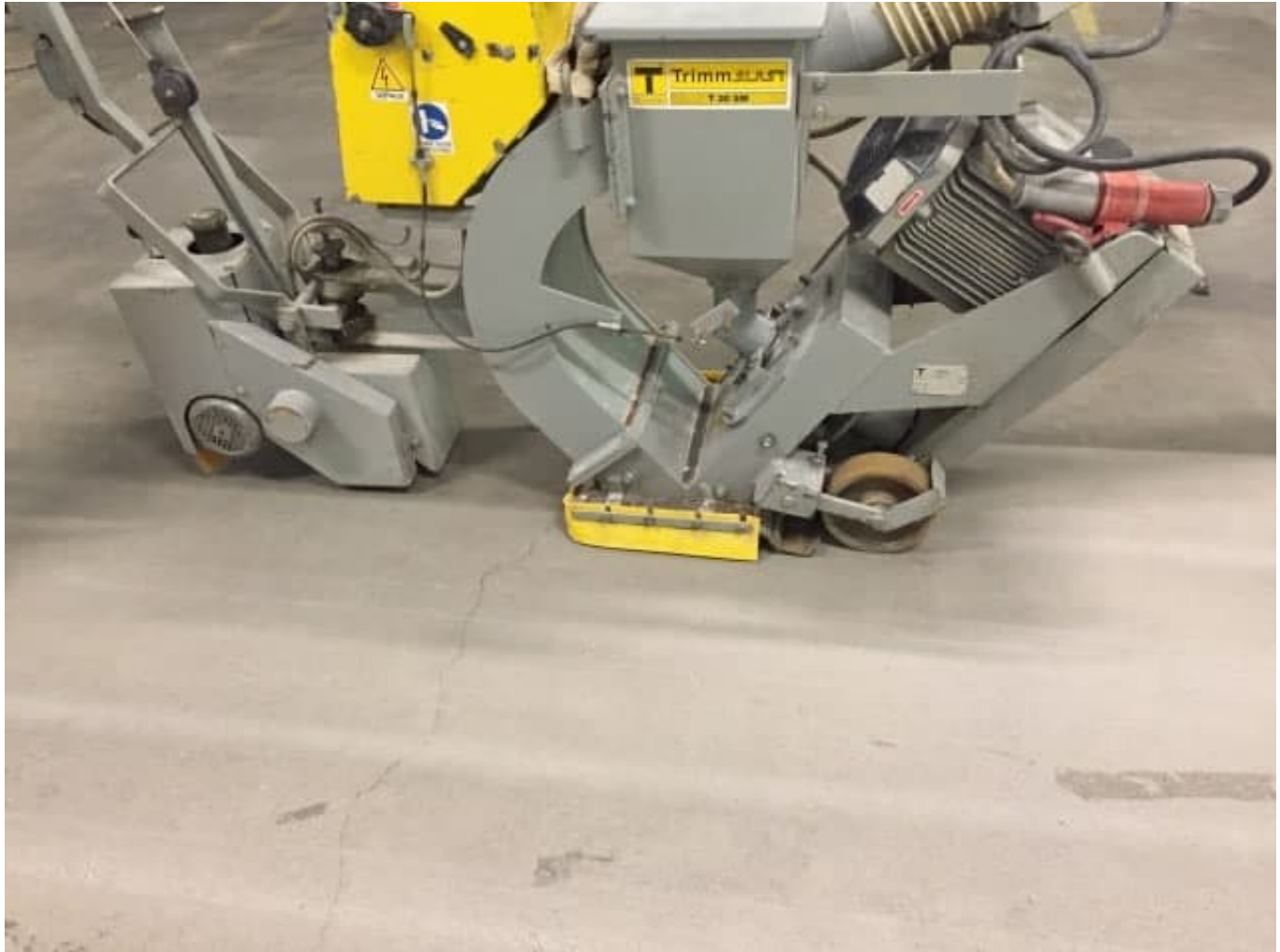
Golvblästerutrustningen i arbete.
