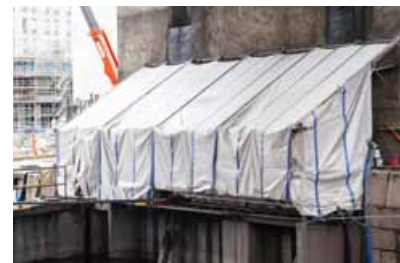
Arbetsområdet vid slussportarna var väl tillslutet för att inte riskera att släppa ut något avfall.
